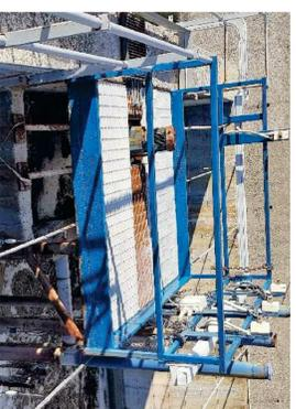
"balconcino" speciale trapezoidale per passaggio tubi ed ispezione interna per la vasca di bilanciamento
