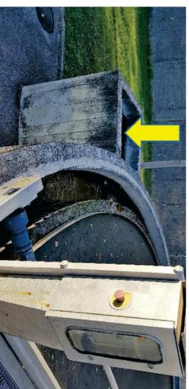
Piastra di chiusura del pozzetto laterale esistente sedimentatore primario
